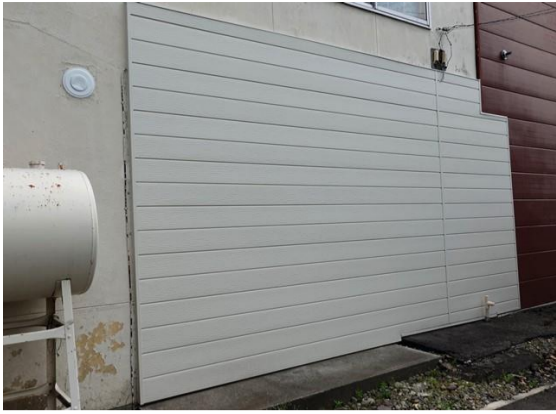
〔後〕 旧玄関部撤去後の壁面
