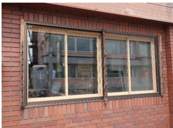
〔後〕 開かなくなっていた窓サッシを交換
