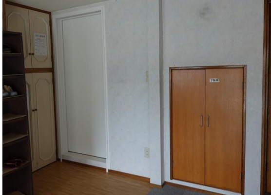
〔後〕 玄関フロアの前面左部に引戸を設置
