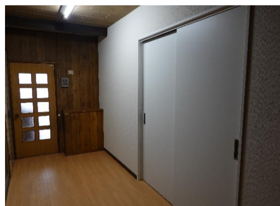
〔後〕 廊下を作り物置に入る引戸を設置
