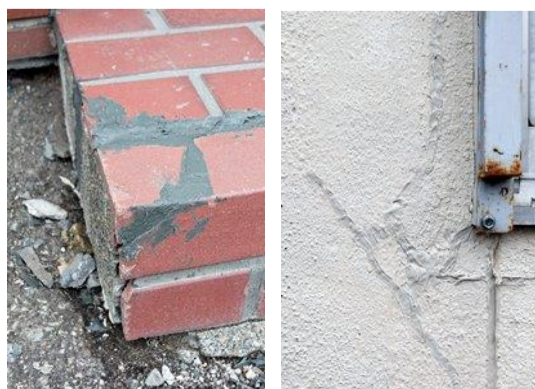
会館ひび割れの補修後の一例です。
